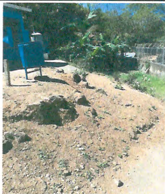
Foto 1: La Comunidad educativa prioriza muro perimetral para el establecimiento
