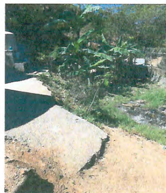
Foto 2: La Comunidad educativa prioriza muro perimetral para el establecimiento
