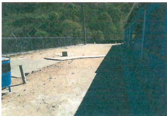
Foto 3: La Comunidad educativa prioriza la pavimentación del patio deportivo del establecimiento
